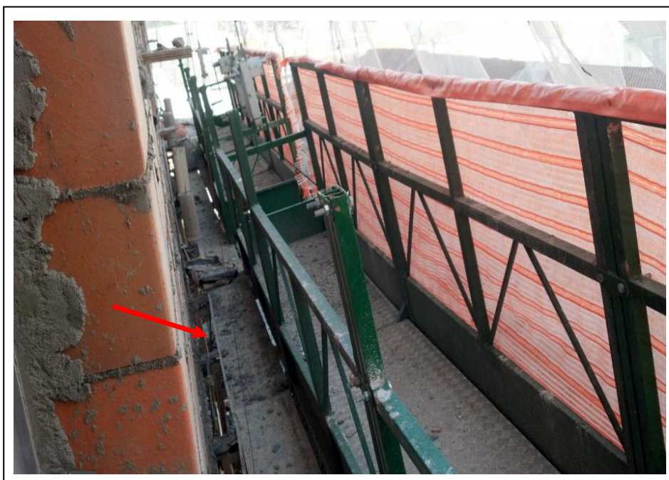
Figura 46 – Bandeja de proteção afastada da fachada Fonte: Arquivo pessoal (2015)
